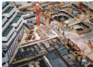
Работы на строительстве
